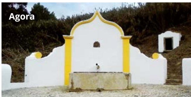
Recuperação da Fonte do Farrobo na Estrada do Farrobo
